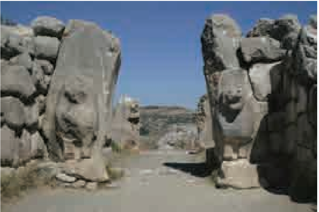
Resim 28: Aslanlı Kapı, restorasyondan önce (2010)
