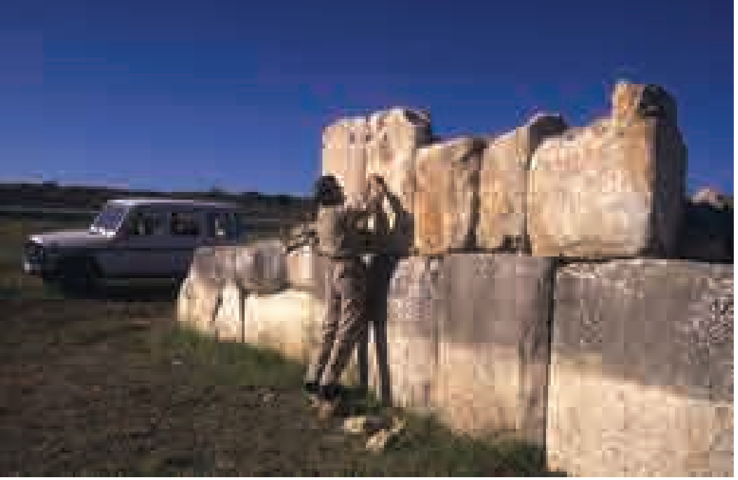
Resim 20: 5 no.lu Tapınak'ın kısmi rekonstrüksiyonu yapılmış subasmanı kesimi ile ortostatların üstüne yerleştirilmiş bloklar
