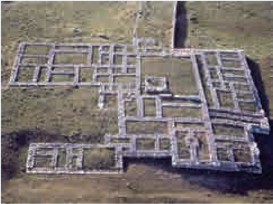
Resim 7: Yukarı Şehir’de 5 no.lu Tapınak’ın restore edilen temelleri
