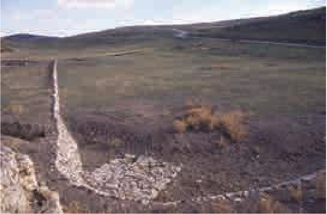
Resim 17: 1 no.lu Doğu Havuzu'nun kuzey köşesindeki eğimli havuz kenarının döşemesi, restorasyondan sonra
