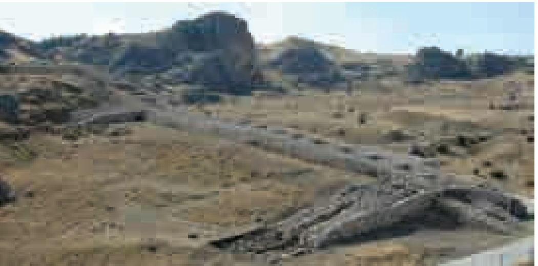
Resim 14b: Poternli duvarda restorasyonun tamamlandıktan sonra şehir tarafından görünüşü (2015)
