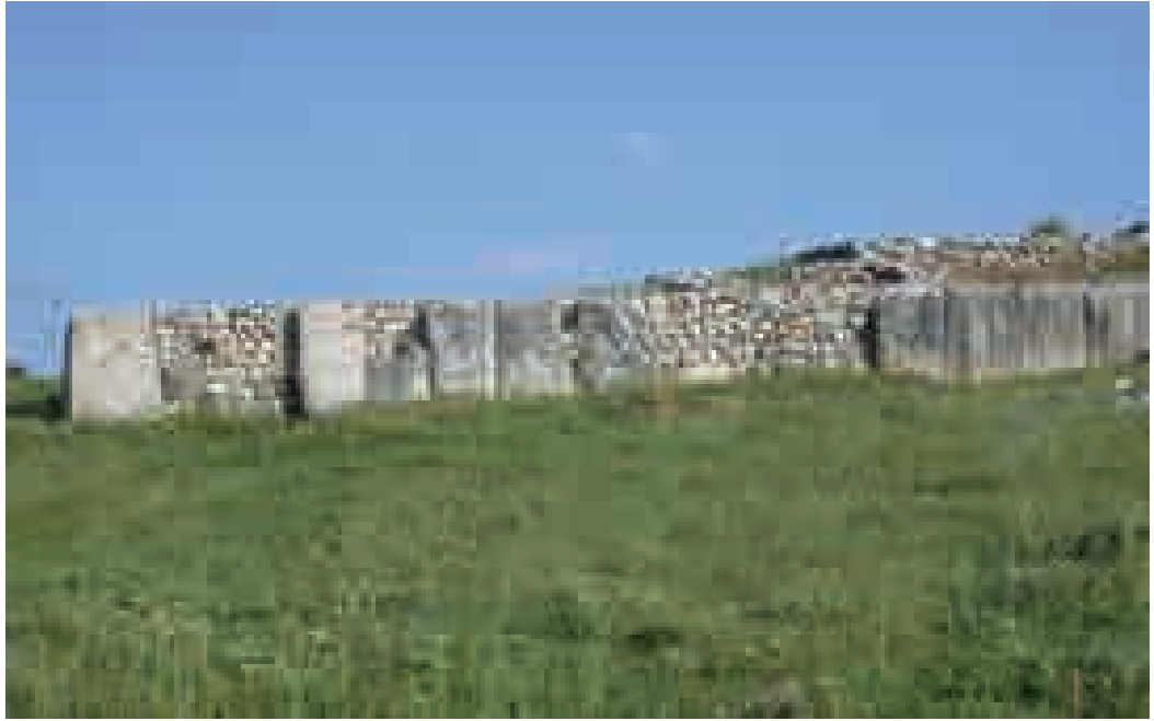
Resim 8: Yukarı Şehir’de 5 no.lu Tapınak’ın ortostatlarını kullanarak yapılan duvar. Eksik blokların boşlukları duvarın subasmanı kesiminin platform izlenimini vermek için küçük taşlarla doldurulmuştur.
